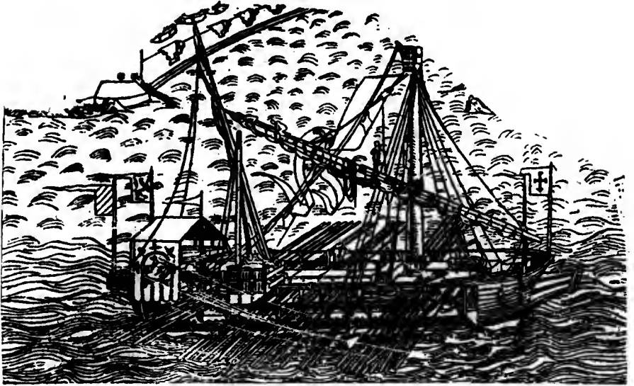
Figur 30. Ruhende Galere, die Thraniten-, Zygiten- und Thalamitenremen zeigt. In beiden Galeren sind die Ruder aus den Rojepforten gezogen und auf Deck gebracht, was stets notwendig war, wenn die Galere segelte oder bei Seegang vor Anker lag, um die Ruder vor Beschädigung zu bewahren und das Segeln nicht zu erschweren.
